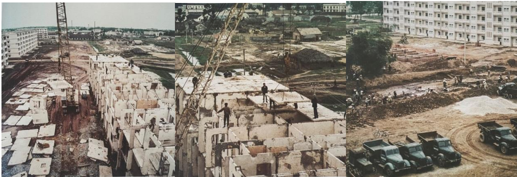
Hình 4.7. Quá trình lắp ghép Khu tập thể Trung Tự năm 1975
