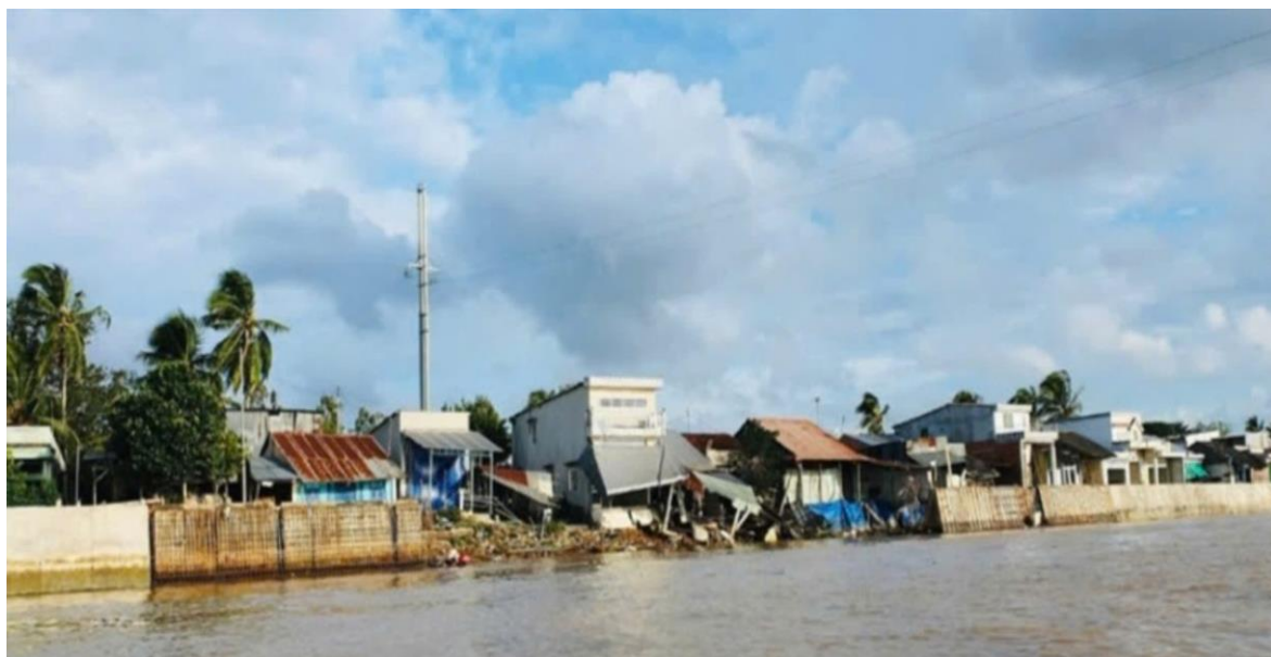
Khu vực sạt lở tại Ấp Thới Lợi, phường Thới An, quận Ô Môn, thành phố Cần Thơ (Ảnh tác giả chụp ngày 31/8/2019)
