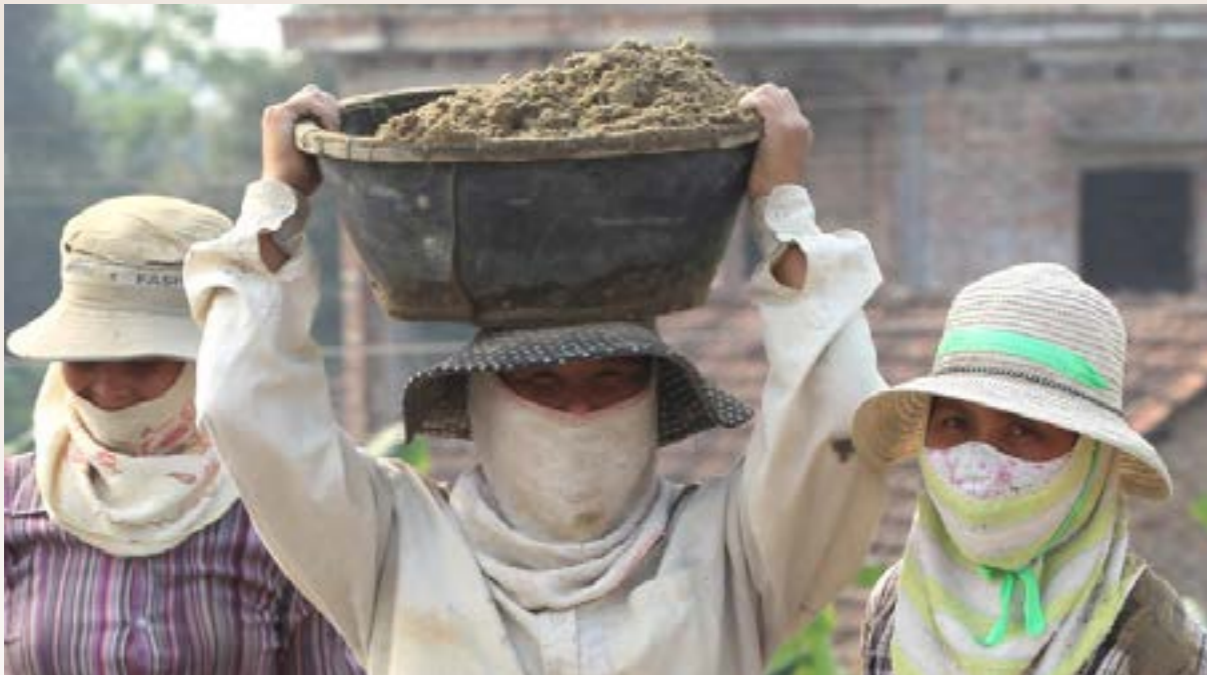
Công nhân xây dựng Nguồn: www.flickr.com
